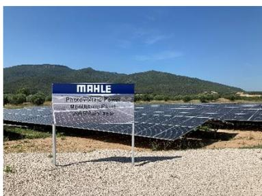
Auf 10.000 m<sup>2</sup> liefert die neue Photovoltaik-Anlage in Montblanc rund 3.000 MWh grünen Strom und spart so rund 700 Tonnen CO<sub>2</sub> im Jahr ein.
